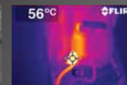
Das sieht eine Wärmebildkamera.
