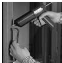
P. ej. encolado de manetas.
